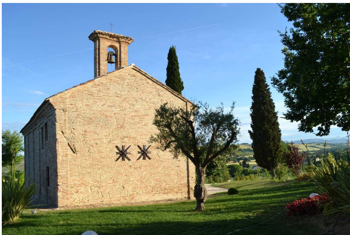
Prospetto nord della chiesa di San Filippo de' Plano
